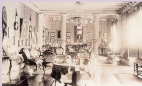
Interior del salón.
